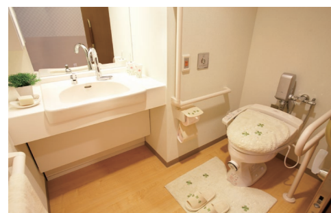
【洗面台】蛇口は自動水栓です。 【温水洗浄便座付トイレ】介助バー、コールボタンも完備
